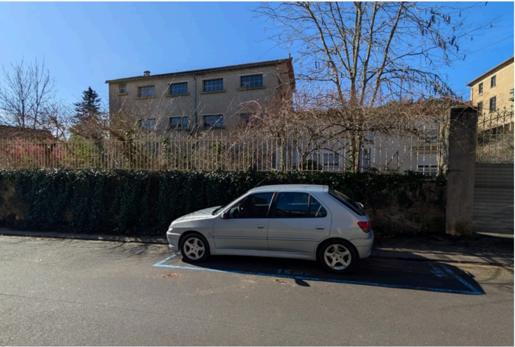
V2 : vue depuis la rue du Porche
