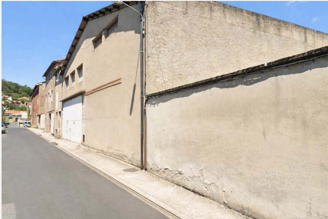
V3 : vue depuis la rue du Porche
