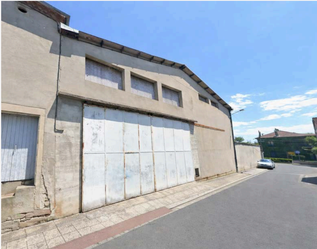
V1 : vue depuis la rue du Porche
