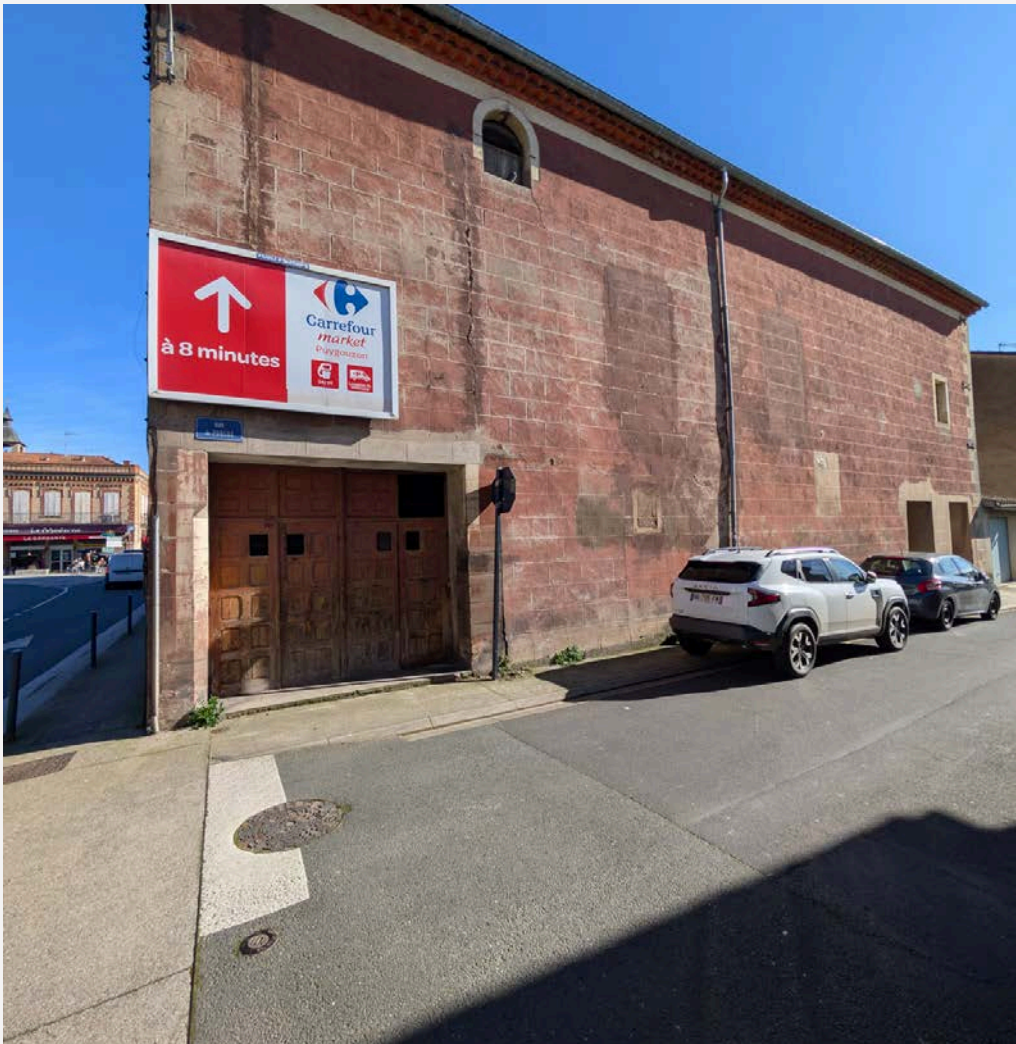
V2 : vue depuis la rue du Porche
