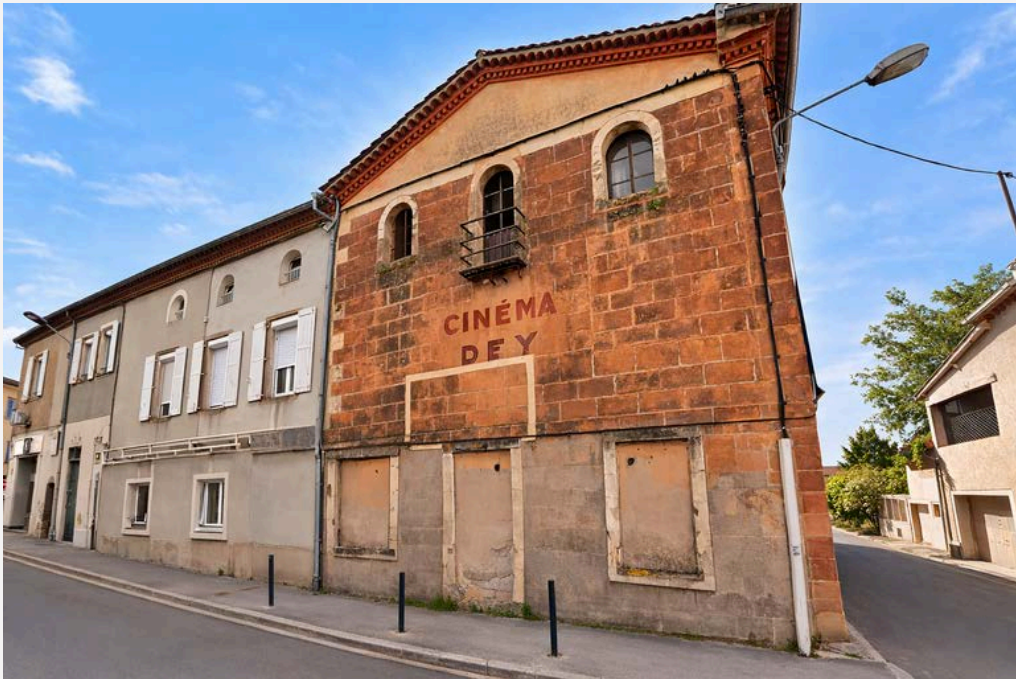
V1 : vue depuis la route de Castres
