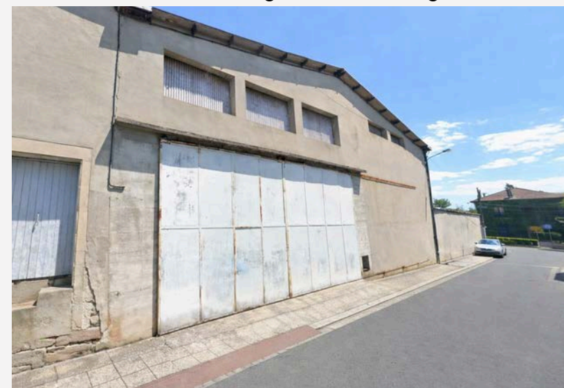
3 Hangar de stockage
