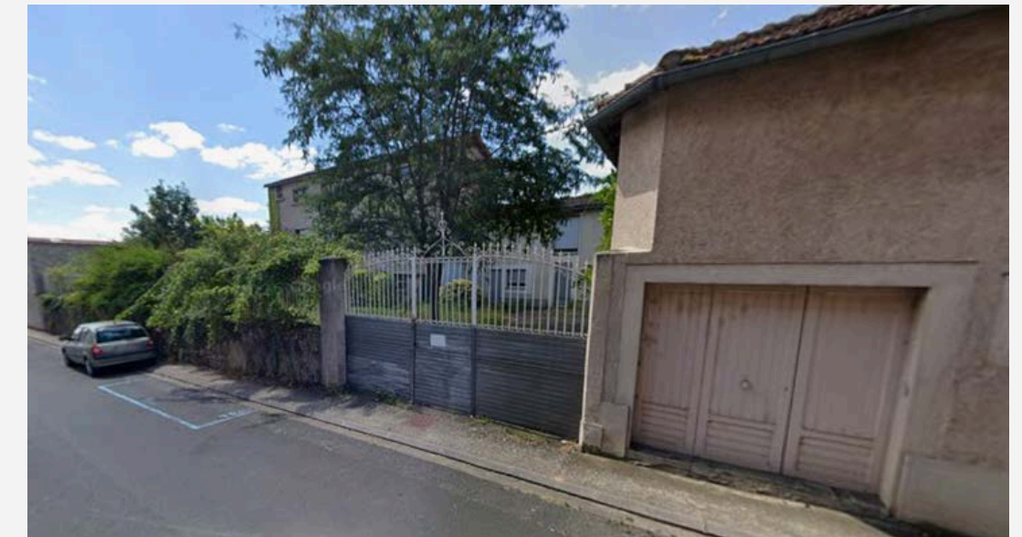
2 Ilot de bâtiments à réhabiliter
