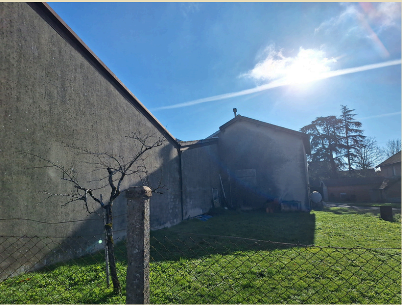
2 Espace libre à l'arrière du hangar
