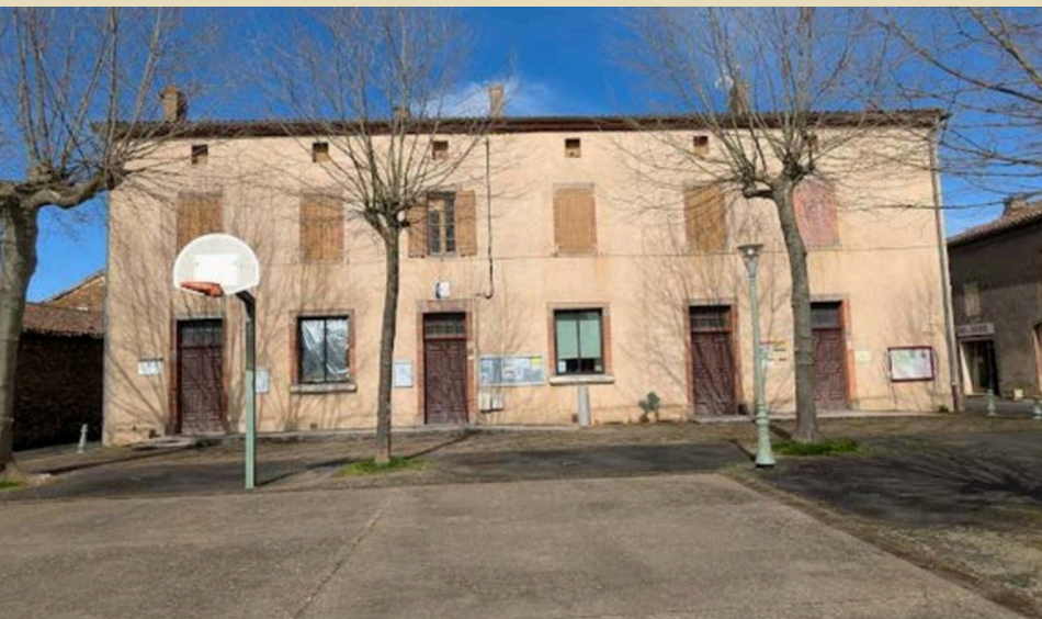
4 Façade de la mairie (ancienne école)
