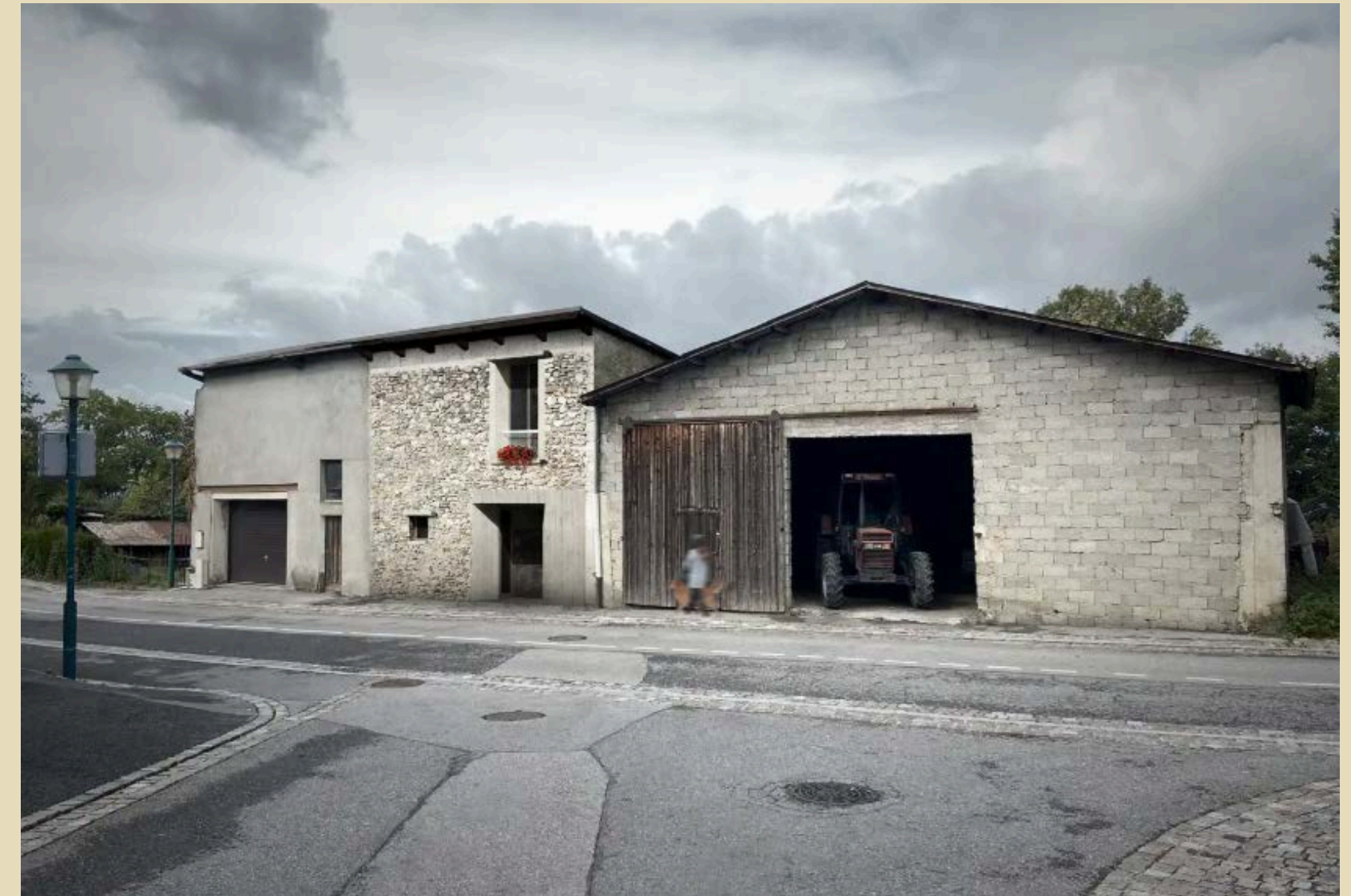
Transformation d'un hangar en atelier (74)
